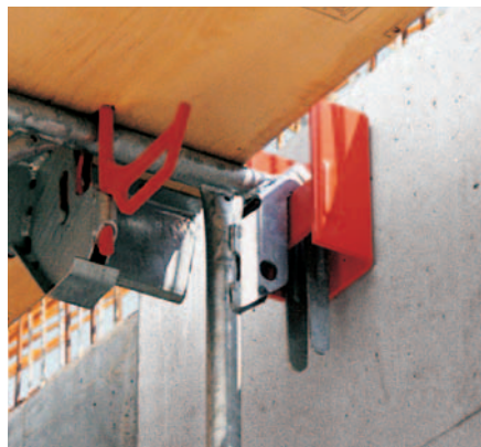
Detailaufnahme: Hauptbühne ASG 160 eingehängt im Aufhängeschuh ASG.
