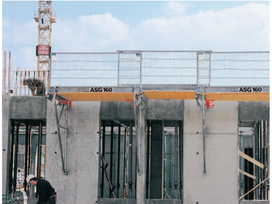
Detailaufnahme: Hauptbühne ASG 160 eingehängt im Aufhängeschuh ASG.
